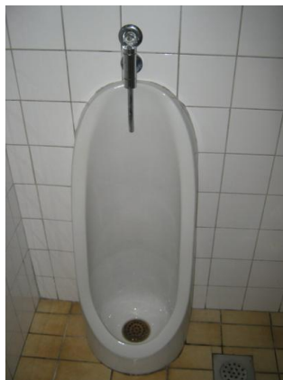
Slika 20: Hranilnik tople vode in pisoar z izplakovalcem na pritisk
