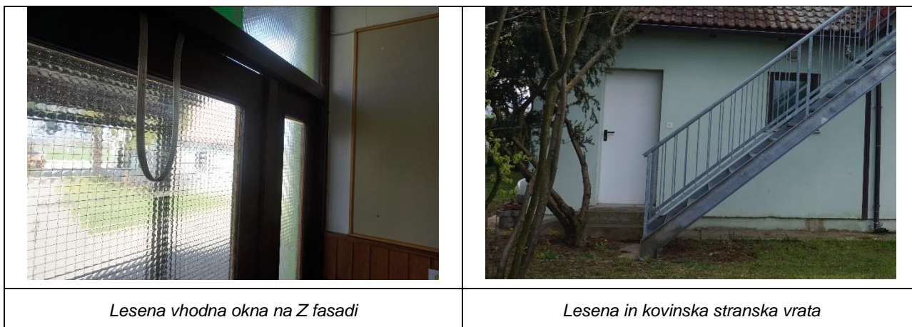
Slika 6.6: Vrata – nastanitveni objekt
