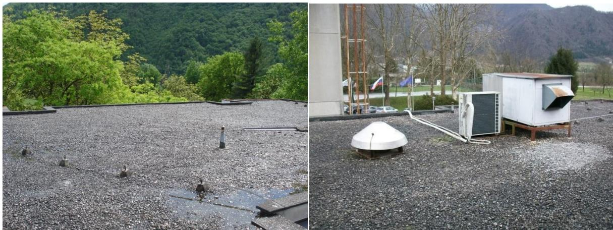
Slika 30: Ravna streha v slabem stanju ter s poddimenzionirano toplotno izolacijo
