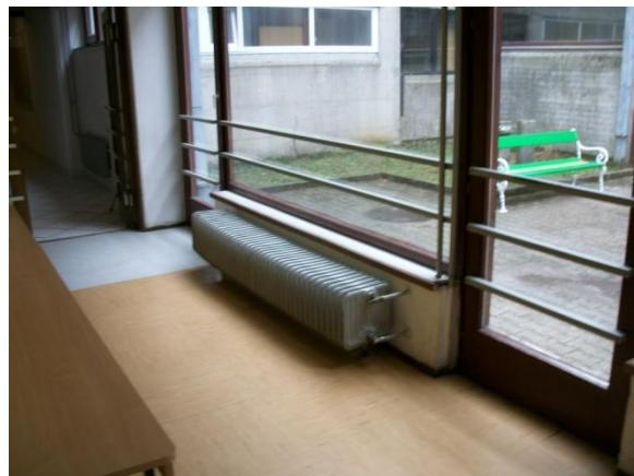
Slika 39: Ogrevalni elementi (radiatorji) brez termostatskih glav
